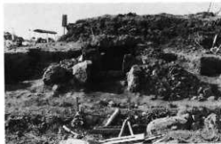
2. 2号古墳石室及び裏込め石（東方より）
