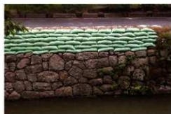
南側竣工 (西から)
