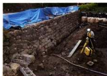
解体修理後石垣の測量
