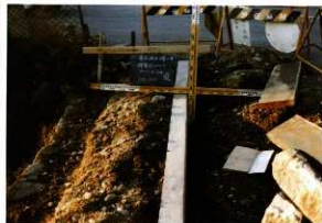
④道路縁石コンクリート壁設置（北端・南より）
