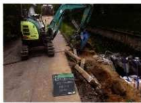
無筋コンクリート撤去工
