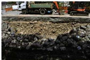
④崩壊土と植生土糞除去後 (西から)
