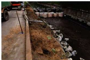
②植生土糞撤去 (北から)
