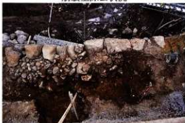
昭和50年度修理(左)と築城時(右)の天端石
