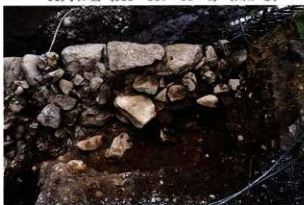
A列石垣と裏込め (東から)
