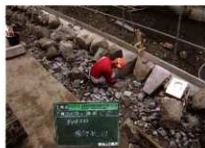
新補材据え付け状況
