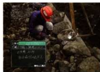
H列木っ蟻石詰め込み工
