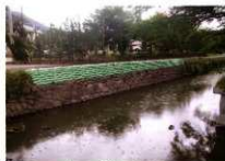
竣工 (北西から)
