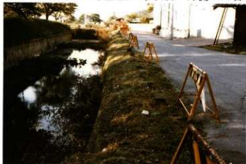
①植生土囊設置前（南より）
