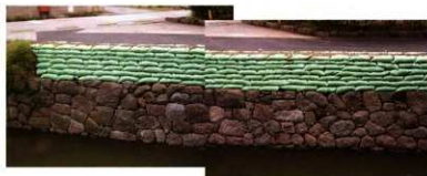
北側竣工 (西から)
