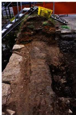
A列石垣（天端石）上面の叩き土（南から）
