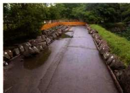
解体築石管理状況
