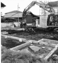
既存建物解体状況
