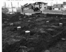
工事立会箇所産工状況
