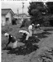
8月調査部分掘削状況
