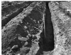
トレンチ掘削状況
