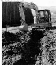
平賀城跡6 掘削状況
