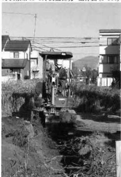
1月調査部分掘削状況
