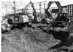
既存建物解体状況
