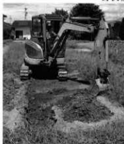
8月調査部分掘削状況
