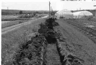
6月調査箇所 掘削状況
