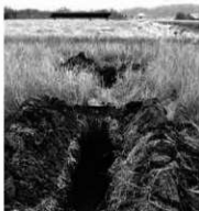
芝添遺跡1 掘削状況
