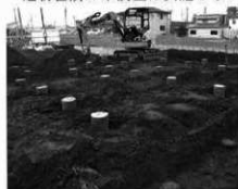
工事立会箇所産工状況
