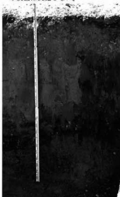
浸透トレンチ掘削箇所堆積状況
