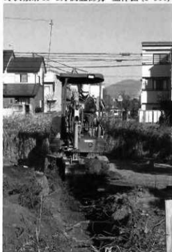
1月調査部分掘削状況
