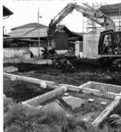
既存建物解体状況
