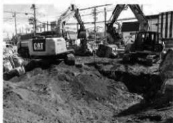
既存建物解体状況
