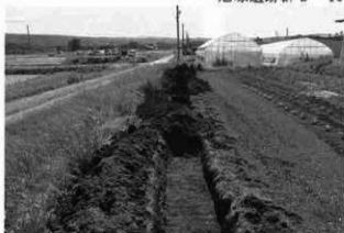
6月調査箇所 掘削状況
