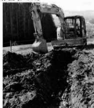
平賀城跡6 掘削状況
