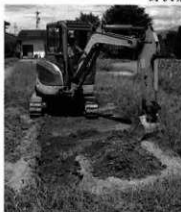
8月調査部分掘削状況
