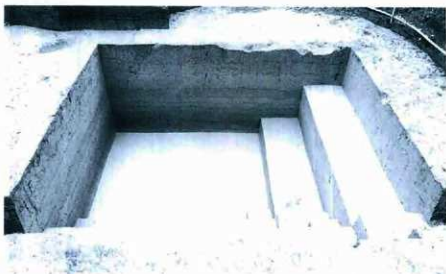
2. 調査坑8全景（南から）
