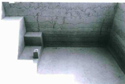
2. 調査坑R土層断面（西から）
