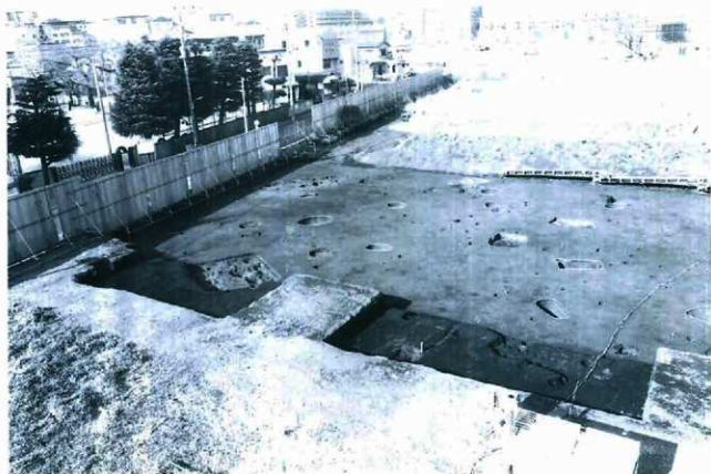
2. 調査区西側全景（南から）
