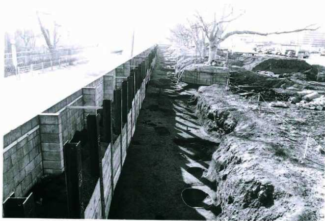
2. 西側調査区全景（東から）
