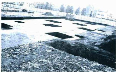
1. 調査坑配置状況（東から）
