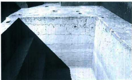
3. 調査坑土層断面 (東から)
