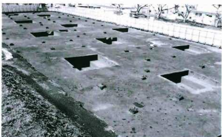
2. 調査坑配置状況 (東から)
