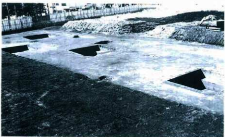
3. 調査坑配置状況（東から）
