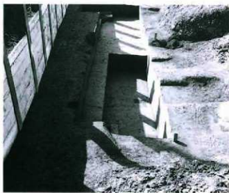
4. 調査坑3 全景 (東から)
