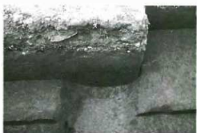
SD201溝断面 (南から)
