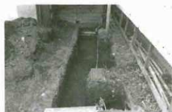
A トレンチ全景（東から）
