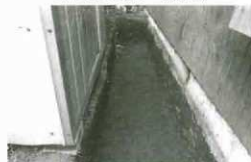
B トレンチ西側全景（東から）
