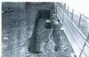
Aトレンチ全景 (東から)
