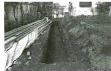
C トレンチ全景 (東から)
