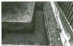
調査区全景北東部（東から）
