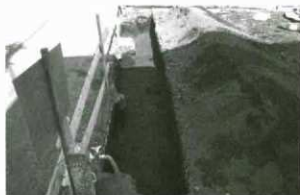
Aトレンチ全景（西から）
