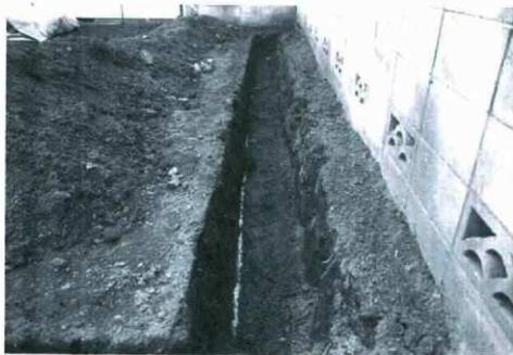
調査区全景北部分（東から）
