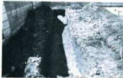
Bトレンチ全景 (東から)
