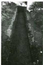
B トレンチ全景（西から）
