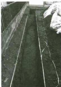
調査区全景北部（西から）
