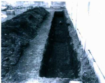
図 1 調査区全景(東から)
