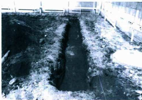
図 1 調査区全景(東から)
