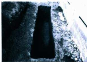
図 2 南トレンチ全景 (西から)
