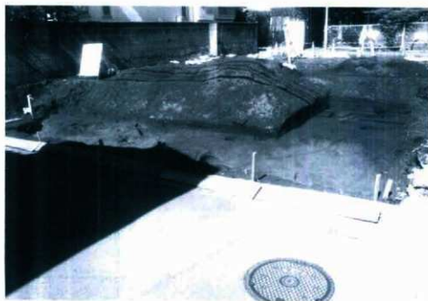
図 1 A トレンチ全景(南東から)
