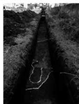
北トレンチの様子
