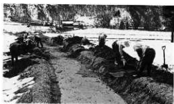
トレンチ底下状況 北より
