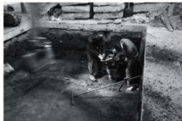
埋め戻しーバックホウ・ランマー使用ー
