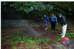
漏水改修工事立会，漏水状況
