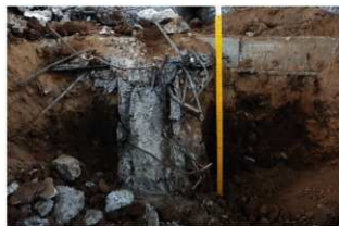
工事立会ポイント11（屋内）
