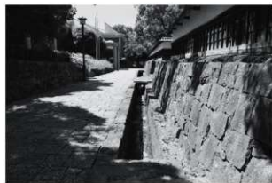
石垣・排水溝・博物館本館建物（東から）
