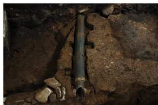
7区 SD01土管露出状況（東から）
