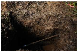
漏水改修工事立会，掘削土層断面
