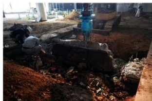
工事立会地中梁撤去作業風景 (屋内)
