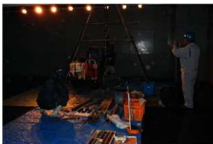
屋内ボーリング調査風景
