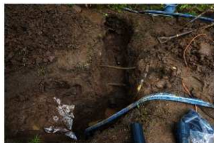
漏水改修工事立会，掘削状況
