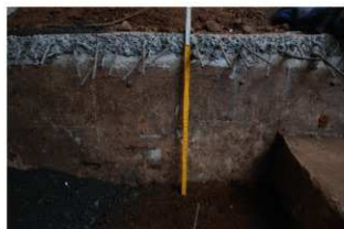
工事立会ポイント21（屋内）
