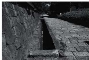
排水溝（西から）
