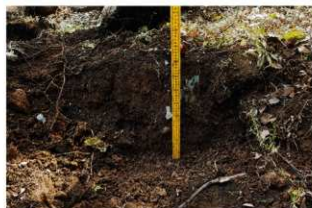
工事立会ポイント31中側（屋外）
