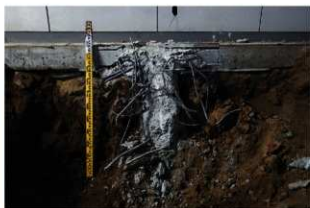
工事立会ポイント7 (屋内)
