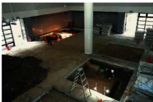
確認調査・本調査区南側（13～24区）
