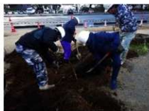
(8)掘削作業風景
