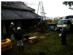
(15) No4 宇土櫓下調査地点
