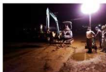
(3) 工事風景 園路東西方向
