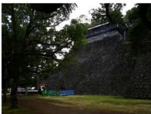
(15) No3 宇土櫓下調査地点
