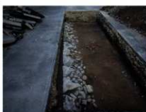
(2) 8トレンチ 間知石溝
