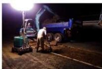
(3) 工事風景 園路南北方向
