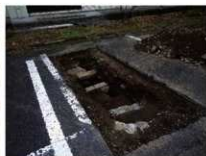
(2) 15トレンチ 煉瓦建物雨落ち溝
