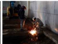
(6) 工事風景 地中梁撤去
