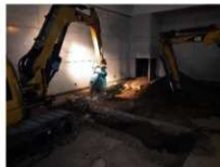
(6) 工事風景 地中梁撤去
