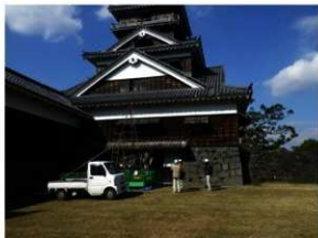
(15) No2 宇土櫓下調査地点
