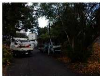
(5) 工事風景 電柱撤去
