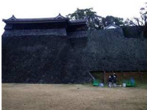
(15) No5 宇土櫓下調査地点
