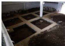
(1) 調査区北側掘削状況
