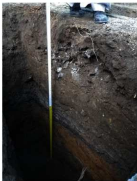
銅板設置部分掘削状況
