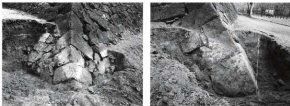
4-3-1-223 図 D.E面(北西隅部)・E.F面(南西隅部)根石状況(図3-1-3・図3-1-4)
