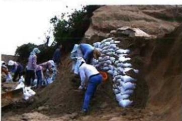
写真8 2005年9月 台風により崩落した砂丘の復旧作業
