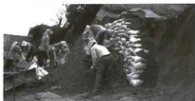
写真8 2005年9月 台風により崩落した砂丘の復旧作業
