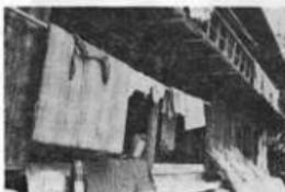
26 下平―小林春男家の隣家出桁、前側と同じくエンガワより裏面に突出している、手すりだけで建具がない
