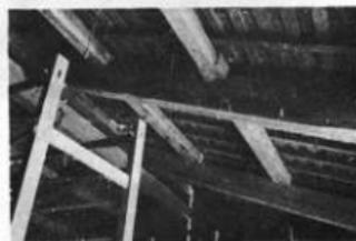
67 中宿一房吉家的小屋組化柱棟と棟木のあいだに巨大なサスが相欠きで組み、上方斜に奥に向うのがモヤ2本その上にタルキ、又、その上にコマイ板、葺地となる
