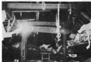
61 下平一半田家の小屋内部仕口穴のあるのがダイコク柱上部、一重のハリの下で、右の柱も下から通柱、二重バりにハりに啓散するモヤが通る。サスは上端空又
