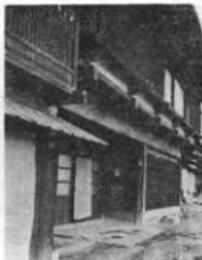
30 坂本中宿―佐藤房吉家の出桁二重の出桁、大きなコウリョウ、中央の柱の正面は8寸・側面6寸と比べるといい。ヒザシがない。
