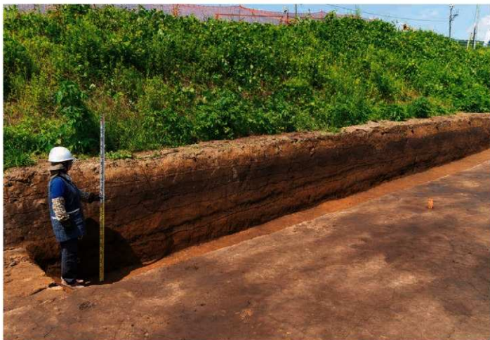
C区南壁 土層断面 ②地点（東より）
