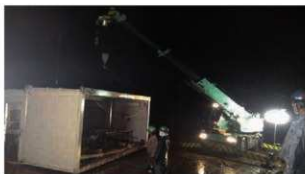
流出プレハブの夜間撤去作業
