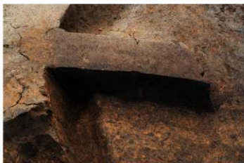
SB30 土層断面 (北西より)
