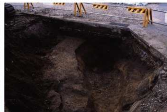
SM5 完掘 (東から)
