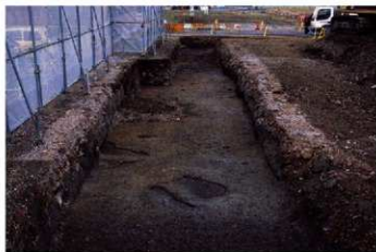
6区 2012年調査 (北から)
