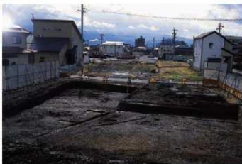
6区 2012年調査 (北西から)
