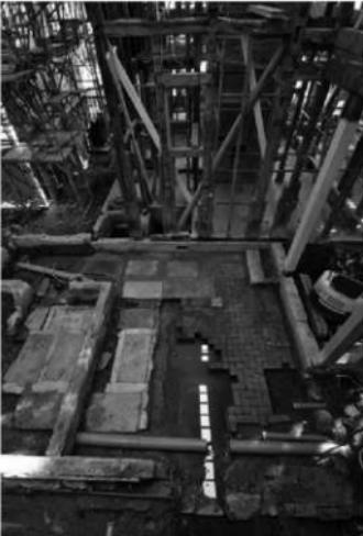
fig.90 付属屋敷石・煉瓦敷き遺構と主屋の窓枠痕跡および基礎石の通気口（北から）
