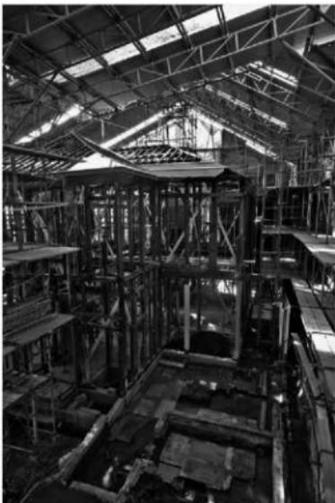
fig.94 解体修理中の主屋と付属屋下層遺構検出状況
