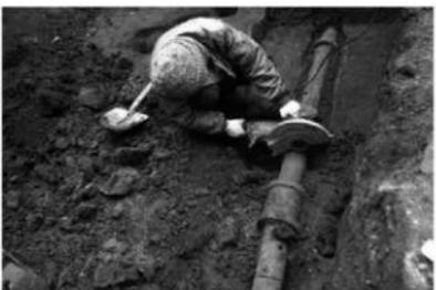
写真34 鋳鉄製上水管の切断作業
