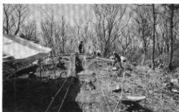
2 北より1・2号塚間トレンチ
