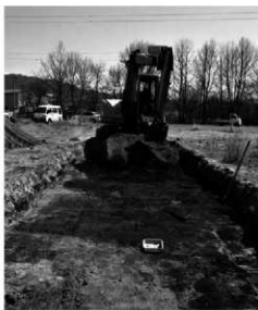
重機による表土剥ぎ状況
