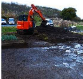
重機による表土除去作業
