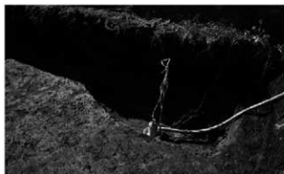
D1号土坑完掘状況(東から)
