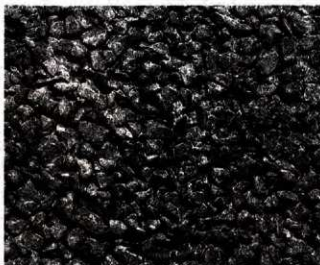
透水性コンクリート舗装の表面
