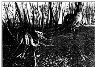
墳頂付近 流土流失によって根が露出している
