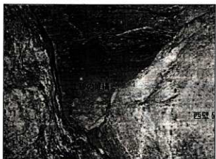
積み石(西壁5)背後の隙間
