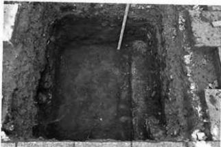
写真80 D地点掘削状況(栗石検出状況)(南西より)
