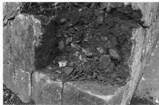
写真18 ⑤区石材取り外し後裏込め石露出状況（南東より）
