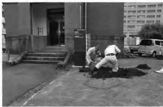
写真83 掘削作業風景(北より)
