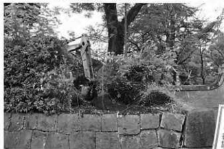
写真17 ⑤区石垣上部裏込め石検出状況（北より）
