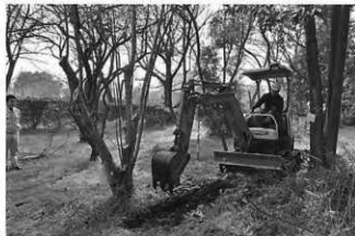
写真151 サンシュユ樹根掘削状況(北より)
