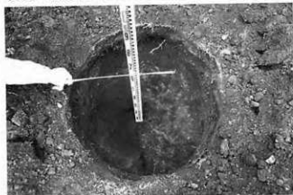
写真84 掘削状況（北東より）
