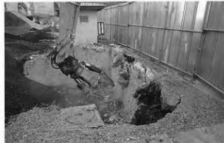
写真104 南側スロープ掘削状況(北より)
