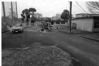
写真187 樹①掘削状況 (北より)
