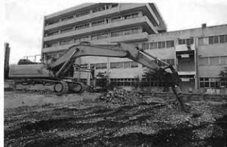
写真101 CDEFG-6・7・8区立会南側掘削状況(東より)
