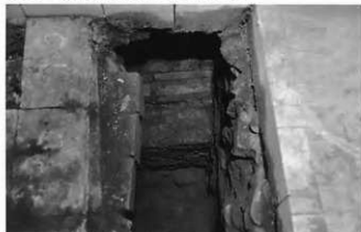
写真58 資料館南側壁体基礎（北より）
