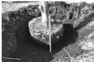
写真31 ②木蓮掘削状況(南より)
