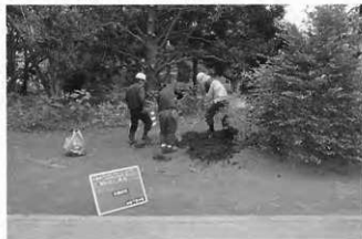
写真26 移植先A地点掘削状況（南より）
