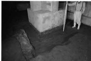
写真108 臨床研究棟 v -14, 15区掘削状況（西より）
