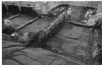
写真100 DE-4・5グリッド樹木伐根作業風景(北東より)
