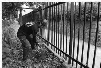
写真14 ⑩区掘削状況（東より）
