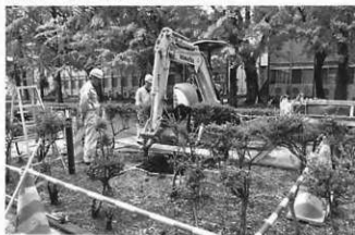
写真76 A地点掘削状況（包含層上面）（東より）
