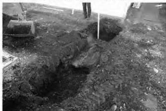
写真189 管理棟西側箇所掘削状況 (南西より)
