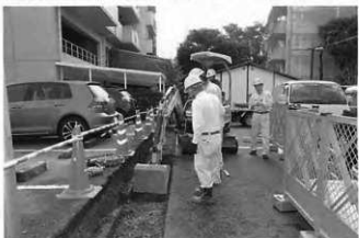
写真111 A地点掘削状況（北より）
