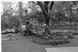
写真37 掘削状況全景(東より)
