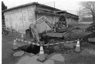
写真191 倉庫南西端給水・排水管箇所掘削状況（東より）
