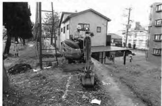
写真164 C地点掘削（北より）
