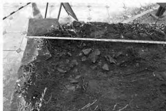
写真18 ⑤区石材取り外し後裏込め石露出状況（南東より）
