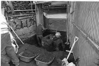
写真41 ②作業風景(北西より)
