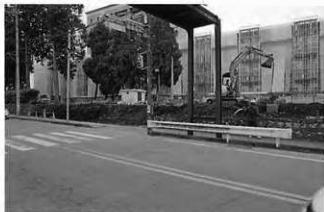
写真64 1d 層位横転検出状況（西より）
