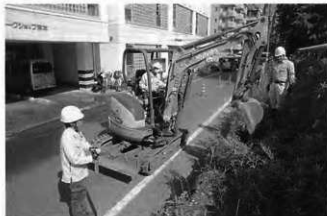
写真118 No①掘削状況(南より)
