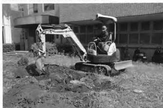
写真134 樹木⑦撤去状況（南より）
