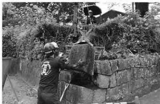
写真20 ⑤区石垣修復後（南より）
