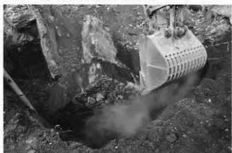
写真72 南西隅基礎解体作業（東より）
