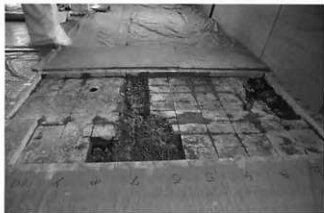
写真53 前建建物柱基礎検出状況（北より）
