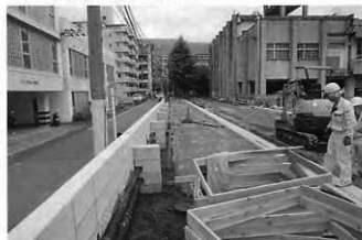
写真127 ②作業風景（南より）
