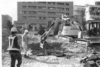
写真70 梁⑭⑮間フーチング検出状況（北より）
