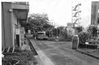
写真141 A地点掘削状況（北より）
