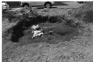
写真198 樹根④撤去完了状況（東より）
