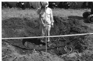
写真135 樹木③撤去状況（南より）
