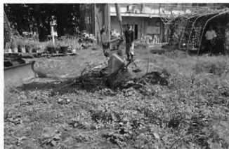
写真137 ①地点作業風景（西より）
