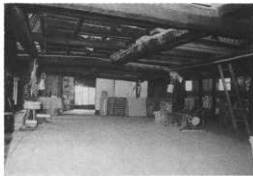
佐藤信一家2階 総2階であるため広々と造られている。 さらに屋根裏（3階）も利用できるように考えられて いる。
