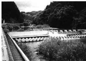
50 原の「大井手」（南方向を撮影）。 左の溝が東講の段丘下面を灌漑する。 左上の山は「丸山」。
