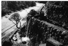
62 広瀬への溝と水抜き装置（南方方向を撮影）。
