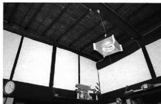
↑ 中の中の大和天井 白川照子家
