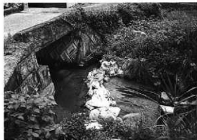
52 東講の溝と宮園川の合流点（南方向を撮影）。 取水期なので土嚢で谷水をせきとめる。
