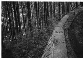
32 山腹を流すをいく高州井手の水路。崩壊が多いため、コンクリートになっていいる部分が多い。
