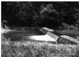
63 「はちべいじえ」の井堰（東方方向を撮影）。
