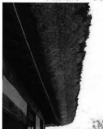
4 屋根 (茅・藁混合葺きの例)
