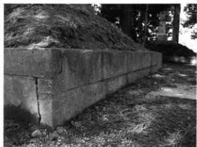
写真7 藩主墓(初代)基壇縁石(切石2段積)
