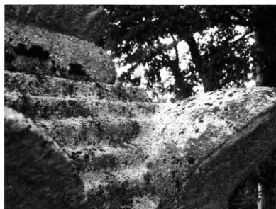
笠 階段状屋根部
