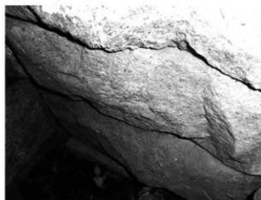
基壇内部 石材加工状況
