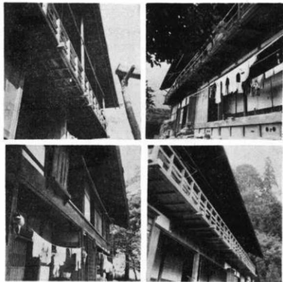
写真2 出し桁各種
