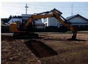
写真 46 重機掘削状況
