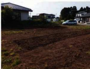
写真14 埋め戻し状況
