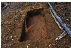
写真101 2 T調査状況
