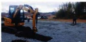
写真 152 重機掘削状況
