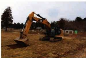
写真 140 重機作業状況
