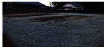
写真 158 埋め戻し作業終了状況
