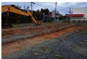
写真5 5T調査状況
