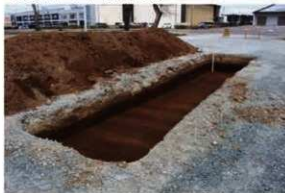
写真 148 2 T 調査状況
