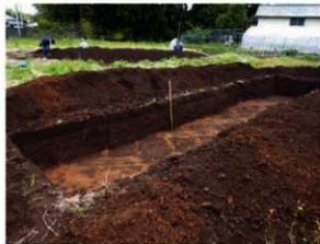
写真37 1 T調査状況
