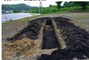
写真184 1T調査状況
