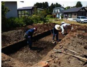
写真8 人力掘削作業状況
