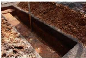
写真 195 1 T 調査状況
