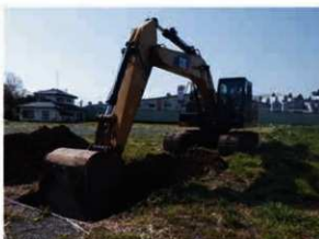
写真2 重機掘削状況
