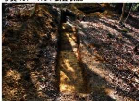
写真 133 114T 調査状況
