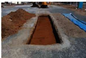
写真 147 1 T 調査状況
