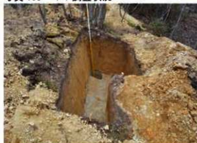
写真110 7T調査状況
