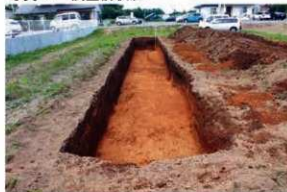
写真72 1 T 調査状況
