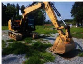
写真 28 重機掘削状況
