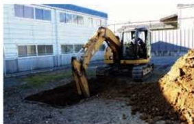
写真70 重機掘削状況
