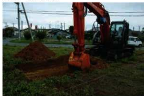
写真 66 重機掘削状況
