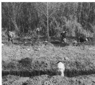
写真15 作業状況(北から)
