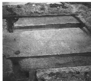
写真9 掘込地業(西から)
