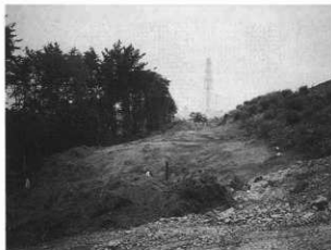
写真24 表土除去後(南から)
