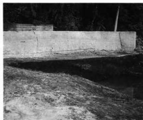
写真8 北斜面土層断面(南東から)
