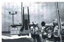
赤尾木橋竣工 (昭和 63 年)
