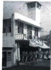
消防会館 (現在の西之表分団詰所跡)
