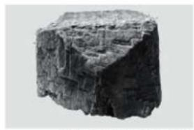
図284 床東鍵板(17)の木口の杭状加工(左)と柱の落としこみ痕跡(右)
