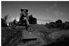
写真1 重機による表土掘削作業
