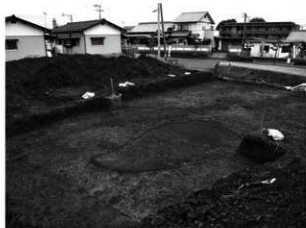
調査区南部遺構検出状況(北西から)
