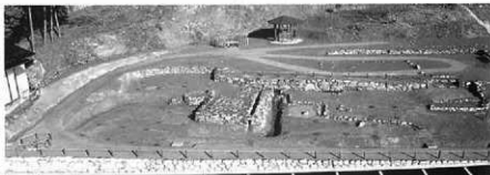
⑩遺跡整備完成全景
