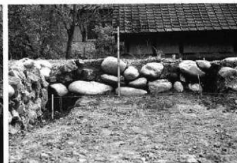
⑧東石垣の脇石垣
