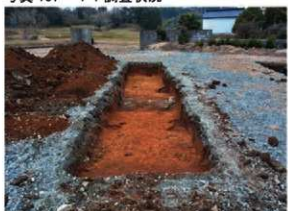
写真 139 2 T 調査状況
