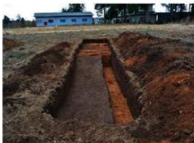
写真 126 1 T調査状況
