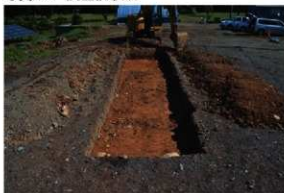
写真95 1T調査状況
