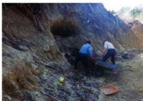
写真43 防空壕調査状況
