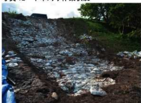
写真 14 ブルーシート撤去状況
