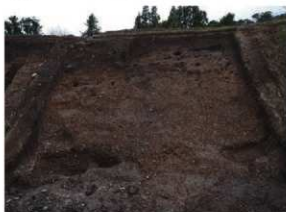
写真 28 2 T 調査状況 1
