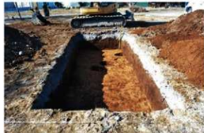
写真134 1 T 調査状況
