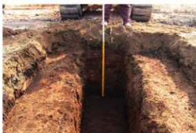
写真136 1T掘削状況
