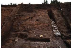
写真 23 1 T 調査状況 1
