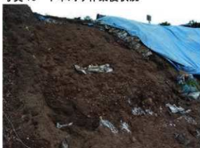
写真 15 土囊撤去状況
