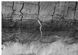
写真27 土層断面の噴砂
