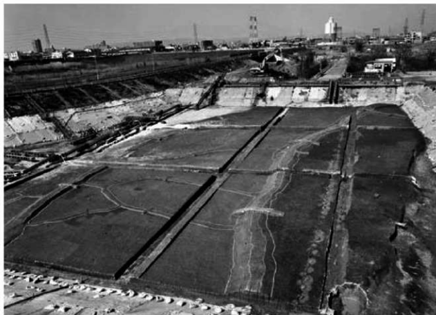
2 第12面 東側全景（南東から）
