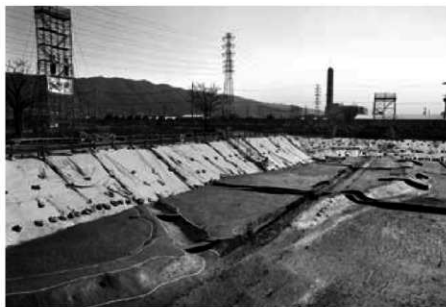
3 第12面 287畦畔と289溝 (北西から)
