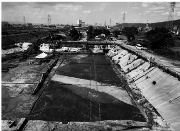
2 第15-2面 東半部全景 (南から)
