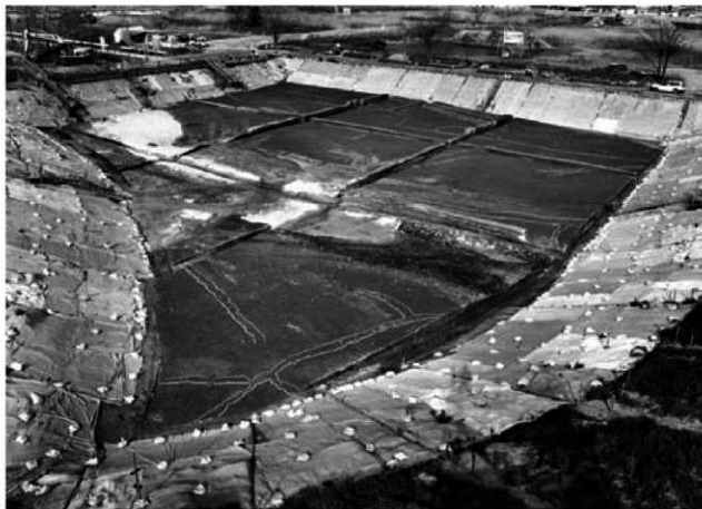
1 第13面 全景（南西から）
