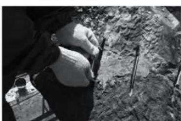
8. 石材修理（アンカーによる笠剝裂部修理）
