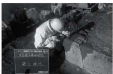
破損部の擬石塗装
