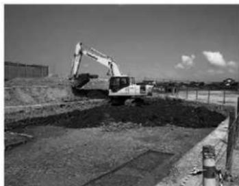
写真2 重機による表土剥ぎ作業 (東から)
