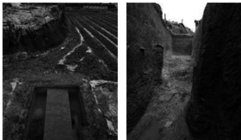
③第6次調査 第1トレンチ墳丘掘
