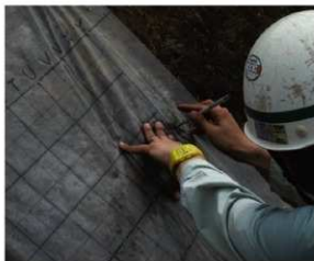
写真2 墳丘崖面の針貫入試験
