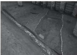
4. 第5-2層除去面検出状況(33・34溝)【北西から】
