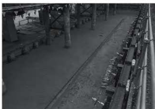
5. 第2-2層除去面検出状況 [北東から]
