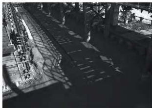
4. 第2-1層除去面検出状況 [西から]
