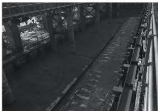
7. 第3-2層除去面検出状況 [北東から]
