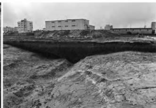
2. 1区 1005流路・弥生流路 断面 (北東から)
