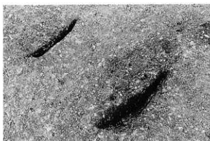
1 建物49 H-9 P-1・2セクション(S→N)
