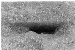
5 P-271セクション(SW→NE)
