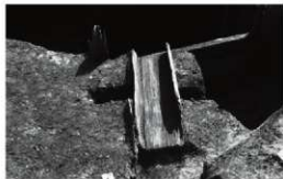
写真7 西木榑取り付け状況（北西から）
