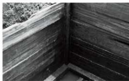
写真8 南東隅柱合わせ目（北西から）
